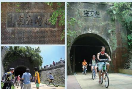
舊草嶺隧道就是台灣民謠中「丟丟銅」歌曲裡提到的「火車山洞」，日治大正10~13年建造（西元1921~1924年），是當時台灣最長的隧道，工程艱鉅浩大且對北宜交通開發史佔有重要地位，自民國75年鐵道改線後廢棄封閉，經重新規劃整建為自行車道，民國97年8月10日正式啟用。隧道全長2,167公尺，隧道南、北兩端出口均以厚4B之磚牆築砌成階梯狀之外觀，洞口高5公尺，形式雄偉，上方以石塊壓頂。二端洞口分別有「制天險」及「白雲飛處」門額，雖歷經歲月的風霜，被煙黑的石額，仍然看的出當年奮動的筆跡。
